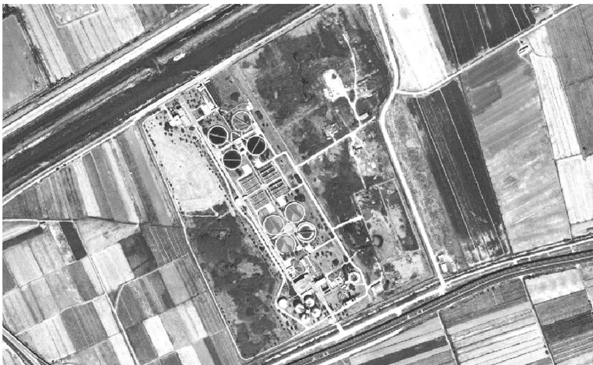
Individuazione planimetrica dell' infrastruttura nell'ortofotocarta del territorio comunale (Tav. 2 degli allegati cartografici)
