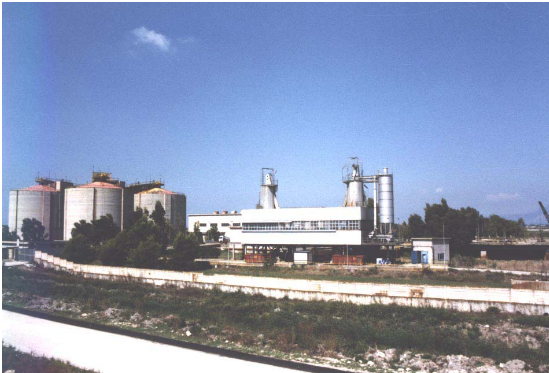
Veduta esterna del complesso del depuratore
